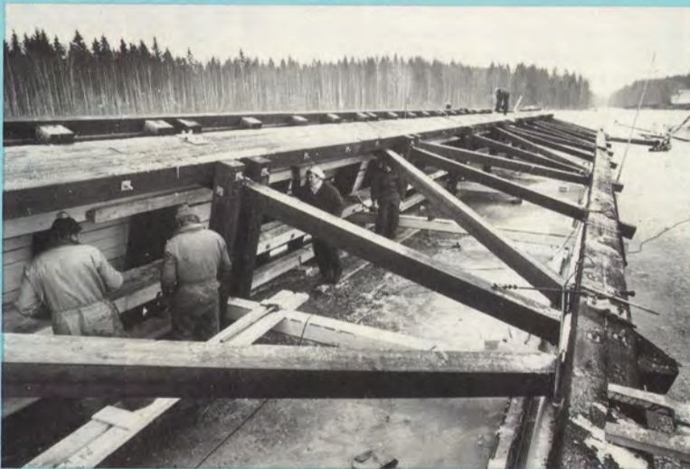
Saukkolassa tehdään neljä uutta uittopuomia Voikkaalle. Jäiden sullettua puomit uitaan jokea myöten sijoituspaikkaansa.
