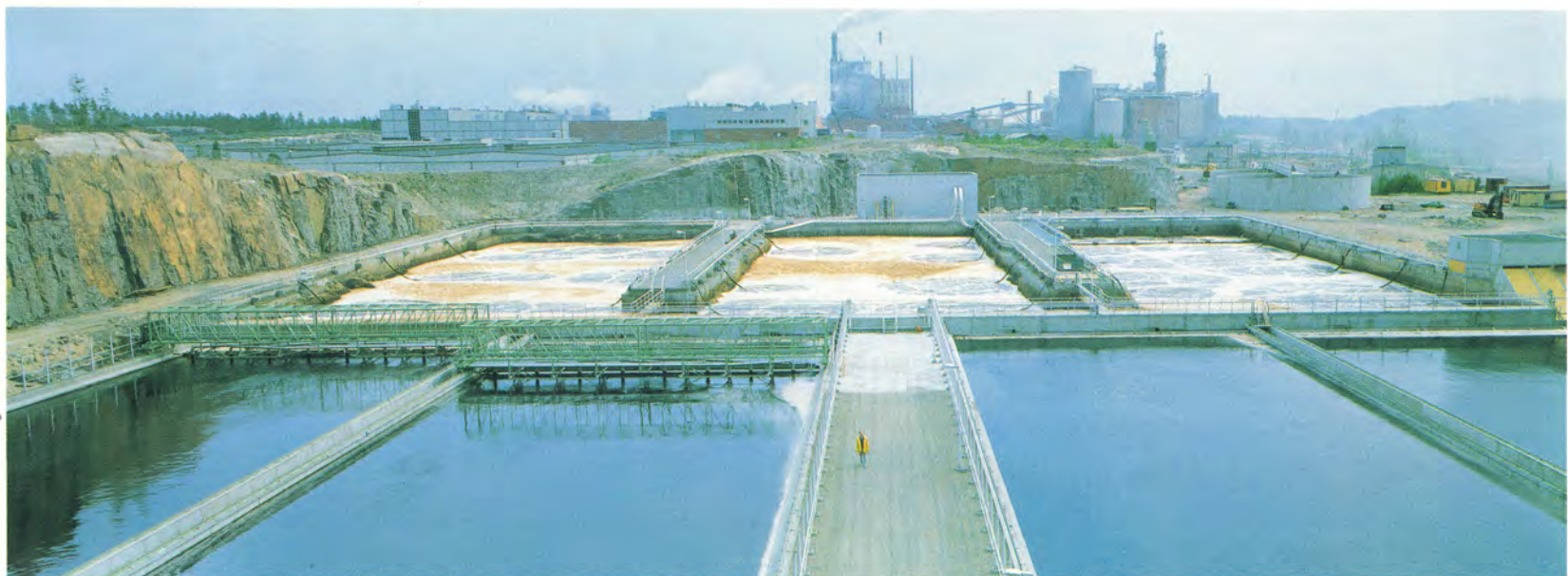
Kuusanniemen aktiivilietelaitoksen toisen vaiheen käynnistymisen jälkeen myös Voikkaan paperitehtaan jätevedet käsitellään Kuusanniemessä. Laajennuksen koekäytöt alkavat elokuussa 1992.
