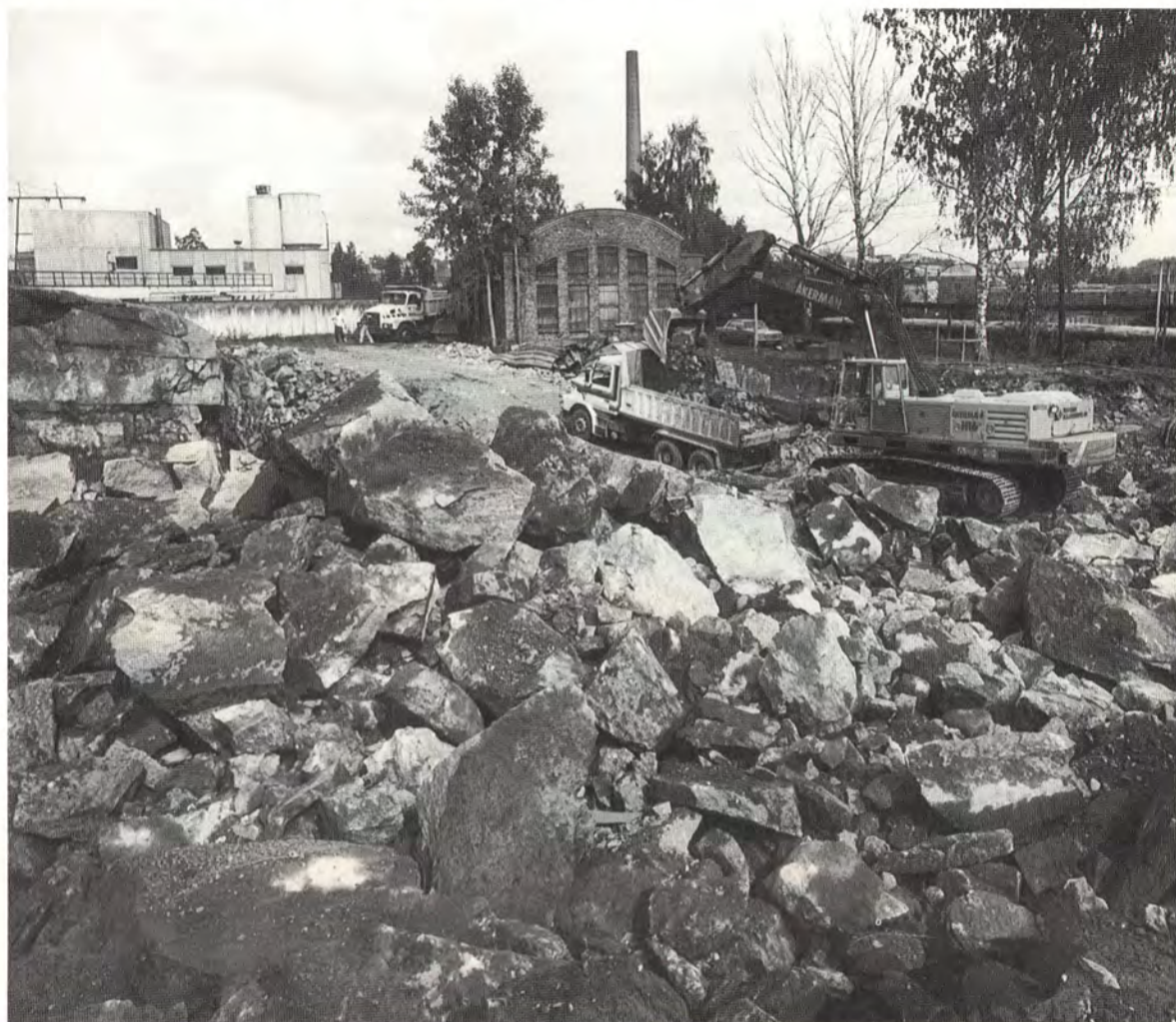
Voikkaalla ovat käynnissä kaivu- ja louhintatyöt.
