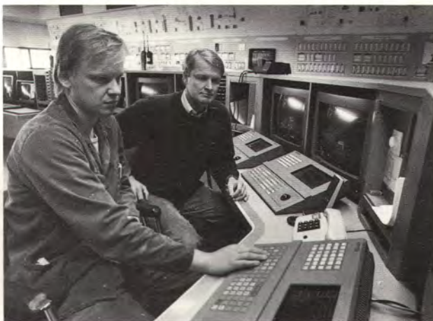
Uutta valkaisuainetta ohjataan keskitetysti 3-linjan ohjaamosta. Sellunvalkaisija Jari Paavola (vas.) ja tuotantopäällikkö Markku Laaksonen Damatic-prosessinohjausjärjestelmän ääressä.
