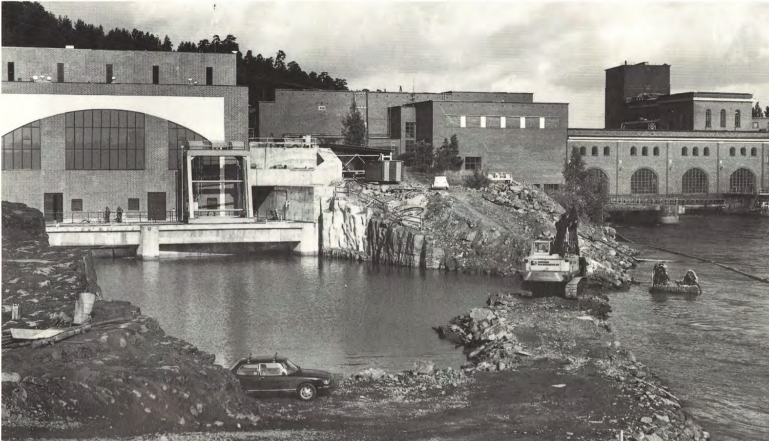
Voimalaitoksen vesikanavat Kymijosta erottavien patokannasten louhinta on käynnissä. Kuva alajuoksun puolelta.
