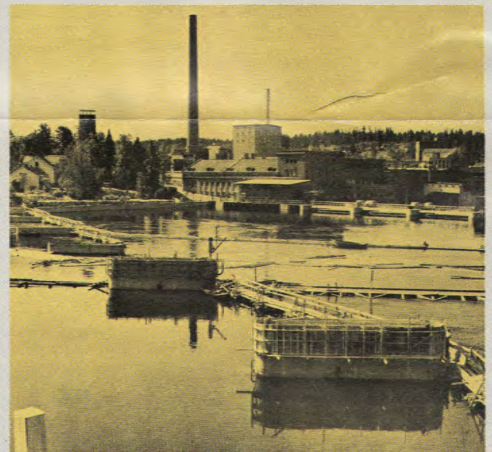
Ekholmin sillan virtapilarit ja maatuet tehtiin vuonna 1940 Kuusankosken vesivoimalaitoksen koskenperkaustöiden yhteydessä. Silta rakennettiin vasta vuonna 1956, jolloin ylläoleva kuva on otettu.
