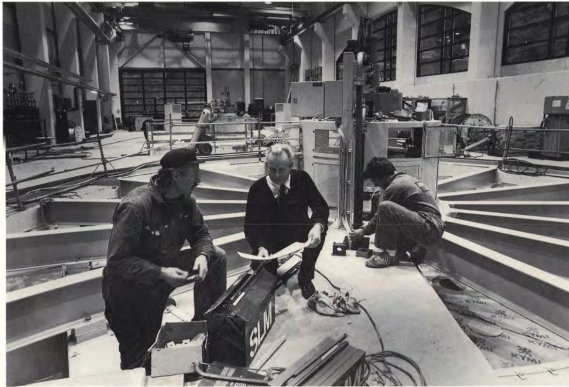
Voimalaitoksen 1-koneistolle tehtiin viimeisiä asennustöitä marraskuun alussa. Vasemmalla koneasentaja Hannu Pelkonen ABB:ltä, käyttöönottopäällikkö Raimo Puranen ja sähkökoneasentaja Ari Mäkelä ABB:ltä.
