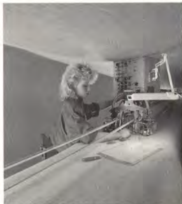
Kuivatusviiraa saumataan saumakoneella.
