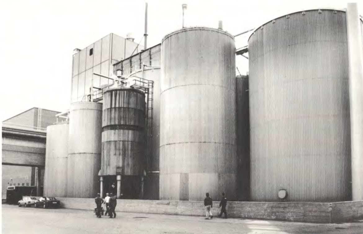
Tarkka ja asetettuihin tavoitteisiin pyrkivä ajo on erityisen tärkeää sellutehtaalla, jossa prosessin jokaisen osan työ vaikuttaa kokonaistulokseen. Kuvassa sellutehtaan haihduttamo.
