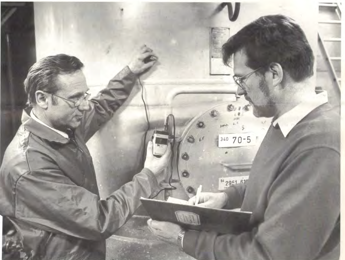
TTK:n paineestiatarkastaja Heikki Purho (vas.) ja Markku Leppäkoski tarkastavat PK 7:n paineilmasäiliön seinämän paksuutta ultraäänipaksuusmittarilla.
