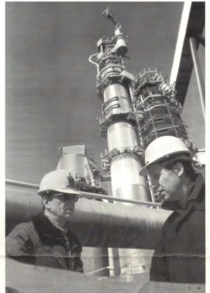
Ensi vuonna käynnistyvän happivalkausinvestoinnin lisäksi 3-linjan keitto uusitaan jo tänä vuonna. Juhannuksen jälkeen käynnistyvän uusinnan asennukset ovat parhaillaan käynnissä. Vasemmalla työnjohtaja Pentti Kaipainen Pohjolan Tehdaspalvelusta ja aikatauluseurannasta vastaava suunnitteluesimies Mauri Ojasalo Kymiltä.
