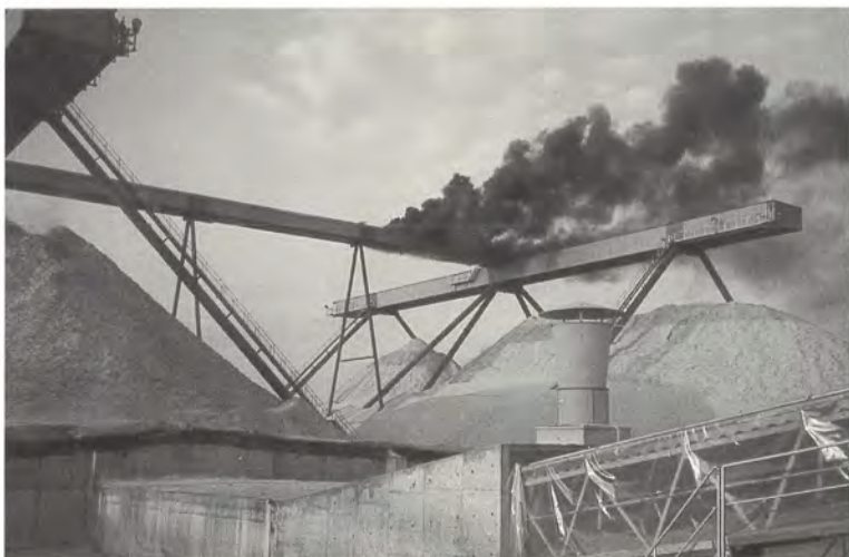
Palo sai alkunsa mäntykasasillan ja kasojen välisen kuljetinsillan risteyskohdalla ...
