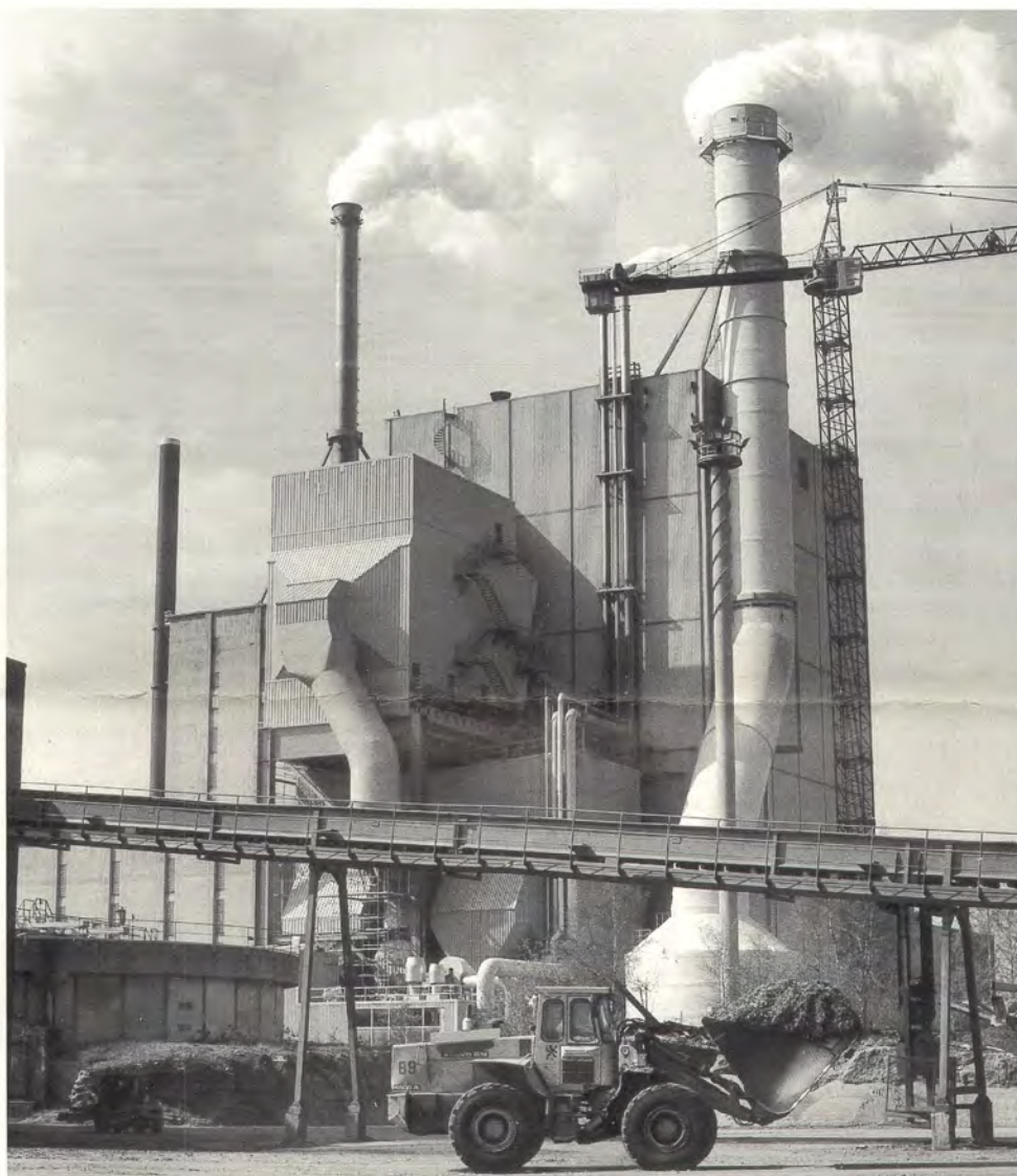
Uusi sähkösuodin on sijoitettu soodakattila 2:n eteläseinälle, vanhojen suotimien yläpuolelle.
