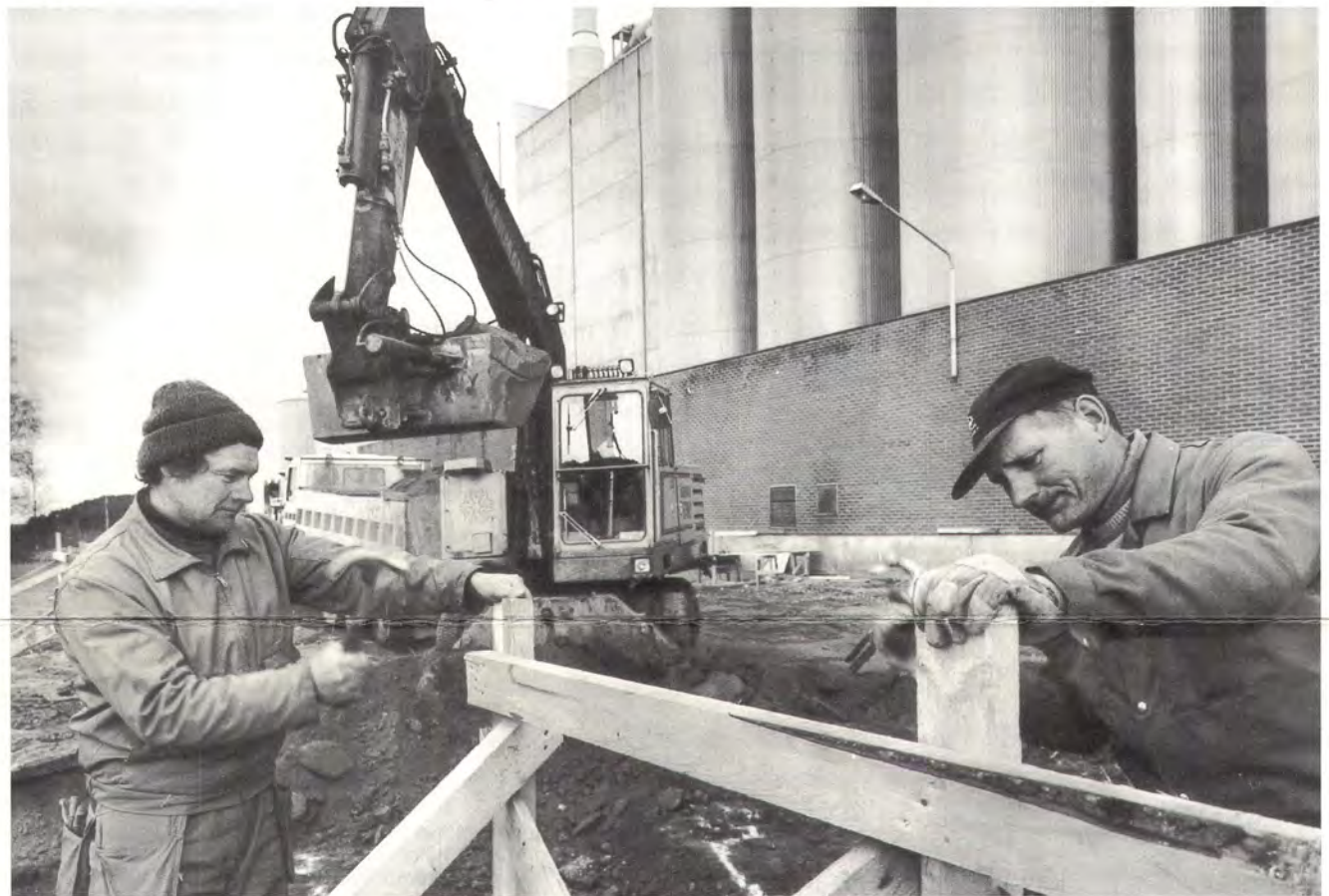
Kaivutyöt alkoivat viikon 43 alussa. Kirvesmiehet Lauri Lintunen (vas.) ja Kari Koivikko rakensivat linjapukkeja.
