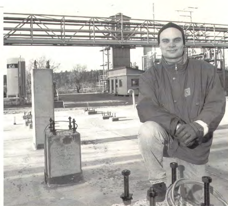
Vetylaitoksen perustusten ja asennuslaatan viimeistely on saatu valmiiksi. Työmaalla käyttöpäällikkö Jari Rutila.
