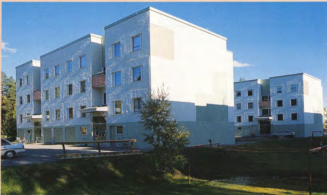
Itäpuiston ja Länsipuiston osalta julkisivukorjaukset valmistuivat syyskuun alussa ja Leikkipuistossa elokuun lopussa.
