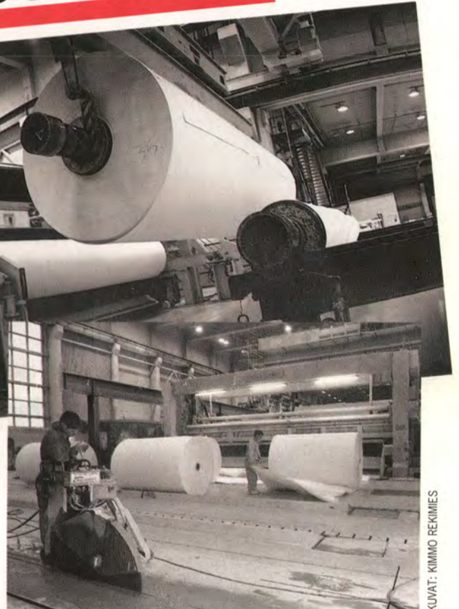
... mutta rullankuljettimien ja uuden pituusleikkurin perustustyöt ovat jo käynnissä.
