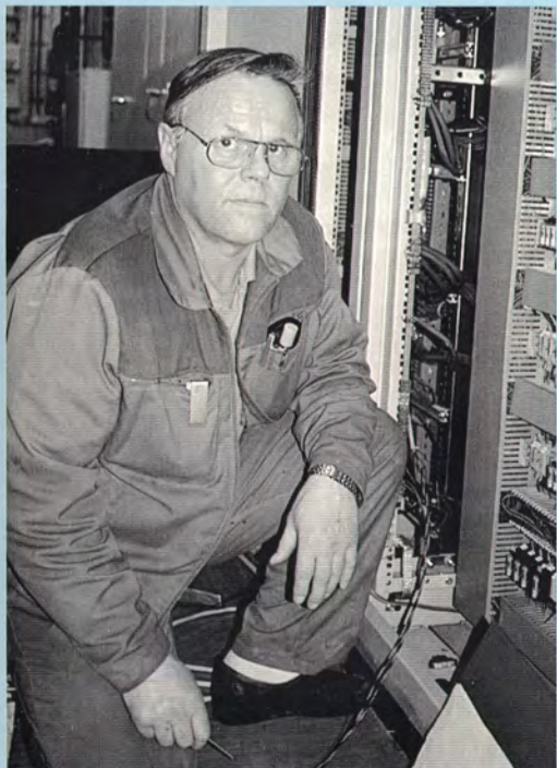
Reijo Sundström teki asennustyötä PK 7:n ristikentätalassa.
