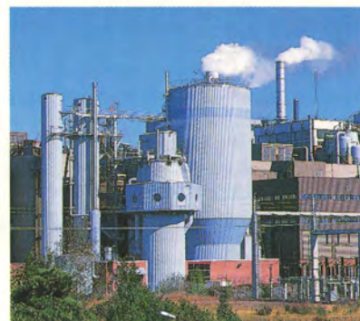
Juhannuksena käynnistyneessä EOP-vaiheessa on samanlainen paineistettu esireaktori kuin happivalkaisussakin (uusi reaktori on vasemmalla oleva kapea torni).
