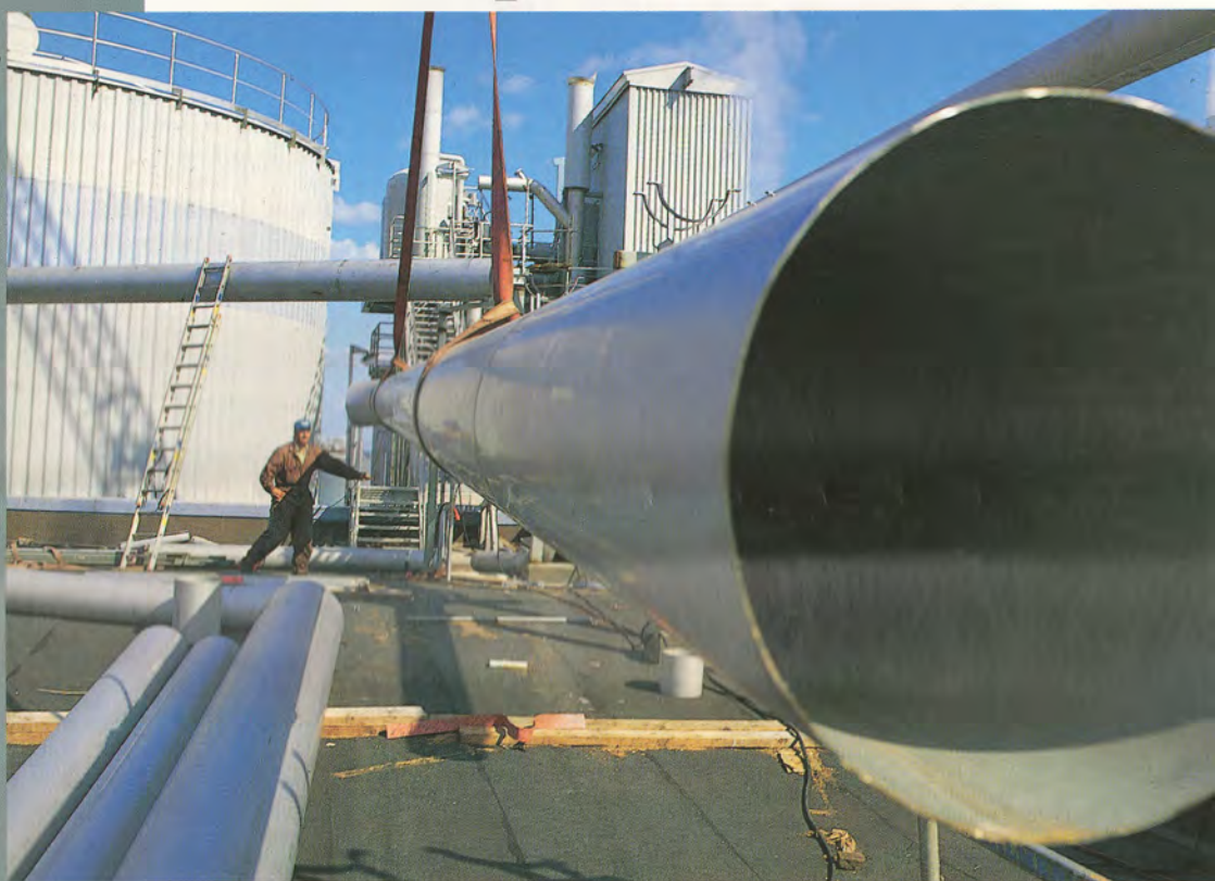
Laimeiden hajukaasujen keräilyä varten Kuusanniemeen rakennetaan yli kilometri uutta putkistoa.
