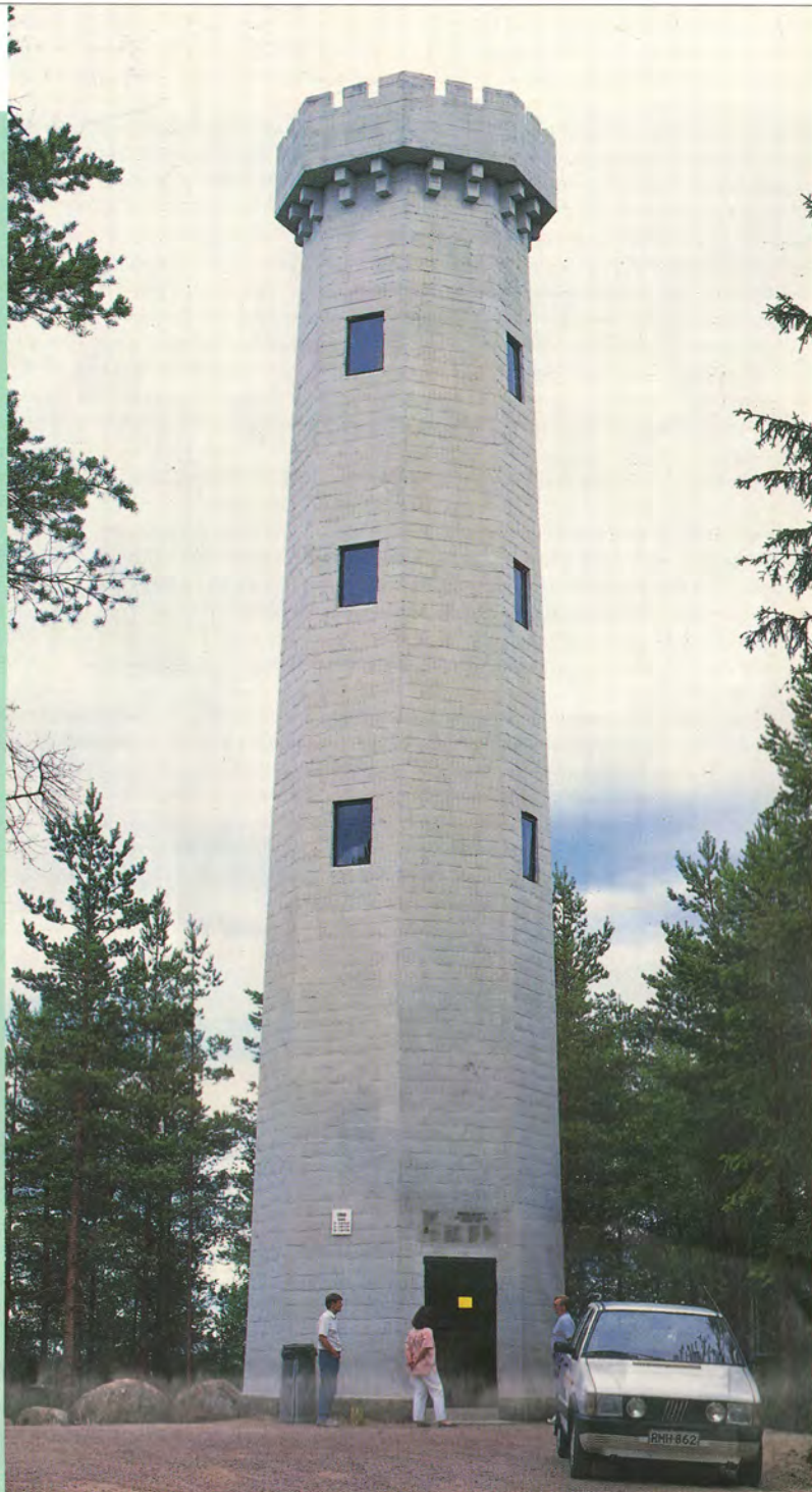
Yli 20 metriä korkeassa kahdeksankulmaisessa tornirakennelmassa on käytetty käsinvalettuja sementtitiiliä.
