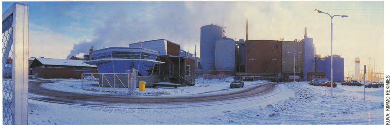
Kuusanniemen liikennejärjestelyt muuttuvat merkittävästi. Uudet portit on jo asennettu paikoilleen ja Kuusanniemessä työskentelevien sekä siellä liikkuvien toivotaan käyttävän niitä jo kylmäharjoitteluvaiheen aikana. Myös autot on syytä jättää uusille pysäköintipaikoille. Jalankulkijoita varten on erilliset pyöröportit, pääportti on tarkoitettu pelkästään ajoneuvoliikenteelle.
