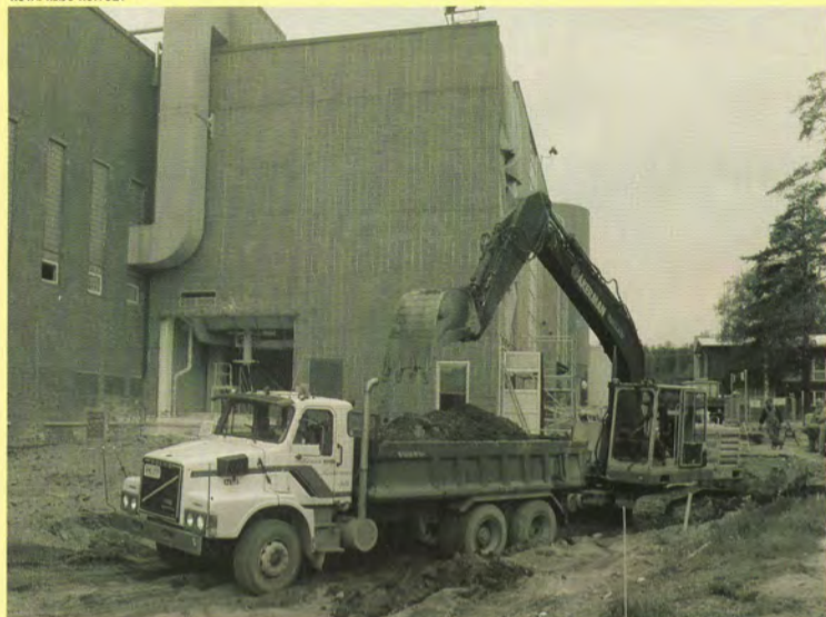
Uuden konehallirakennuksen maansiirtotyöt ovat jo täydessä käynnissä Voikkaan paperitehtaalla.
