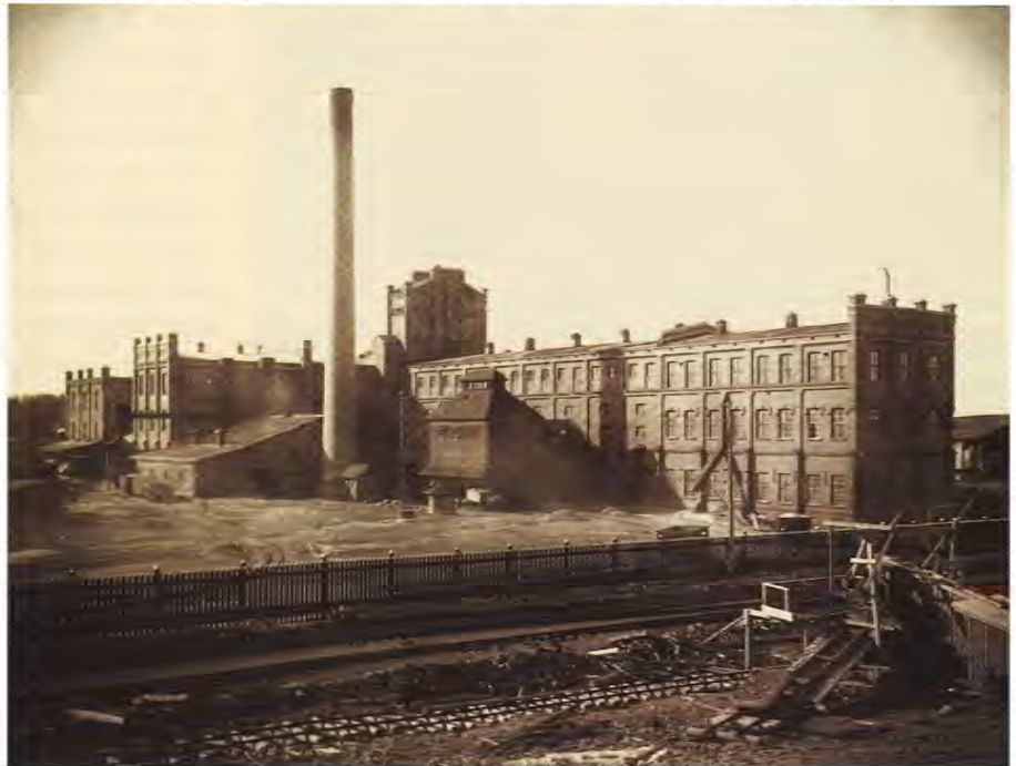
Vuonna 1900 valmistuneessa Kaukaan lankarullatehtaan uudisrakennuksessa Lauritsalassa käytettiin ensimmäistä kertaa Suomessa teräsbetonirakennetta, jonka arkkitehti Lindqvist toi mukanaan maahamme.
