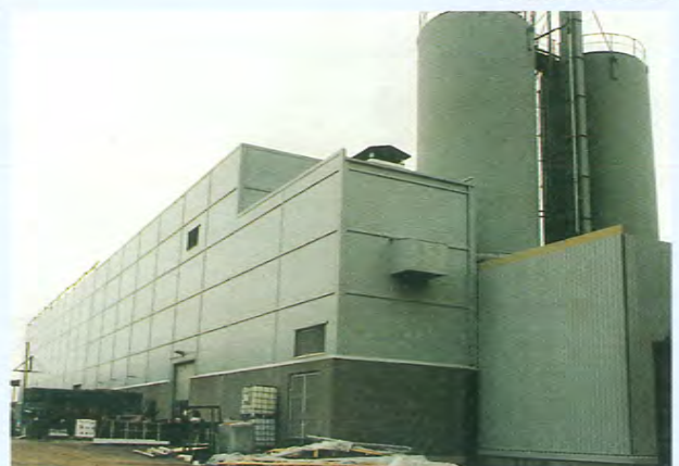
PCC-laitoksella tuotetaan paperin täyteaineena käytettävää saostettua kalsiumkarbonaattia. Uusi laajennusosa on jatkanut laitoksen pituutta lähes puolella.
