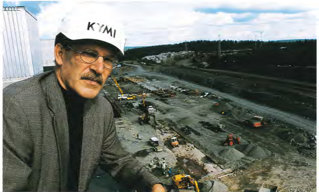
"Artti-projektin työmaalla ovat käynnissä mm. päällystyskonehallin ja päällystyskoneen perustustyöt", toteaa projektijohtaja Harri Pajari.
