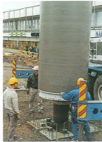
Kolmannen kivitelan pystytys sateisena heinäkuun aamuna suunniteltiin huolellisesti. Kadunsuunnittelupäällikkö Kiukas (vas.) seuraa työn edistymistä.
