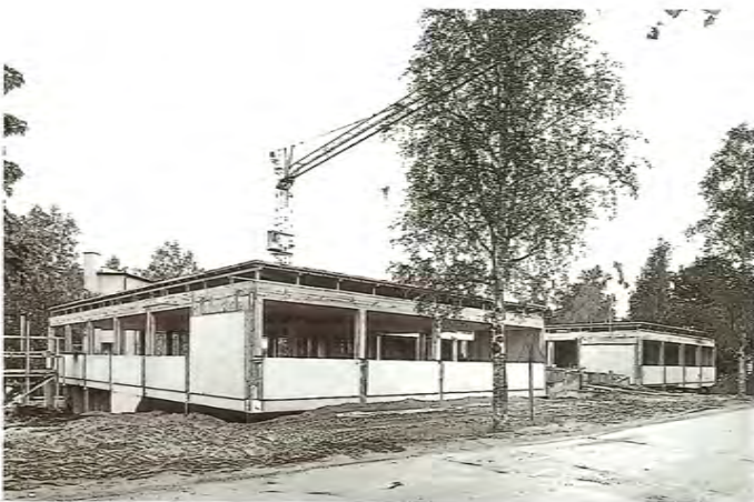
Työterveyskeskus rakenteilla. Talon muoto on jo hahmottumassa.
