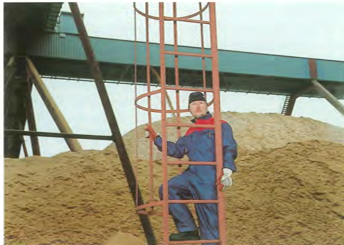
Korkealla sijaitsevien kuljettimien hätäpoistumistiet on tarkastettu tehtailla. Kuvassa Kuusanniemen hakekuljettimia.
