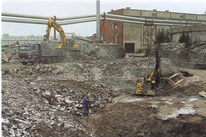
Kymin Voiman työmaa marraskuussa vuonna 2000.
