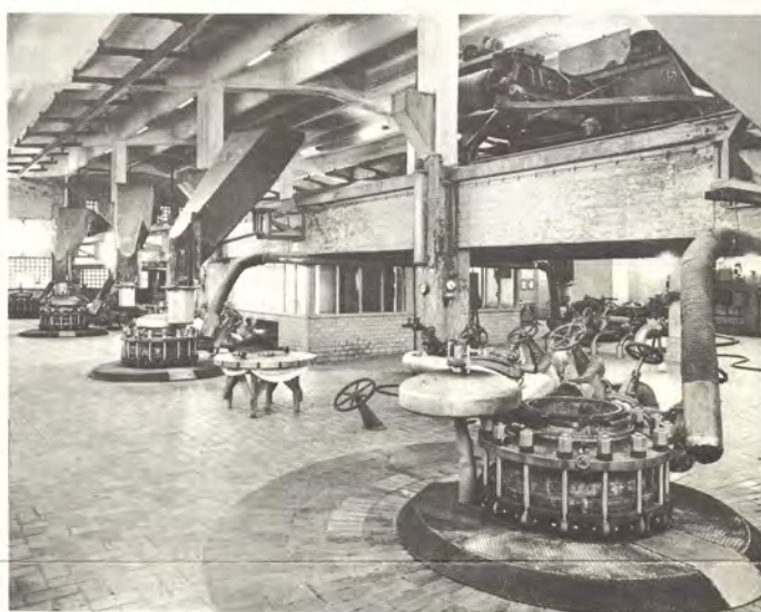
Kymin sulfiittiselutehtaan laitteistot joutavat uusiin käyttökohteisiin. Kuvamme sellutehtaan keittämön yläkerrasta.
