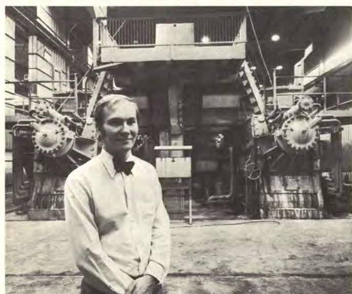
"Tälle paikalle asennetaan viides hiomakonelinja", kertoi Voikkaan puuhiomon käyttöpäällikkö Reijo Yrjövuori.
