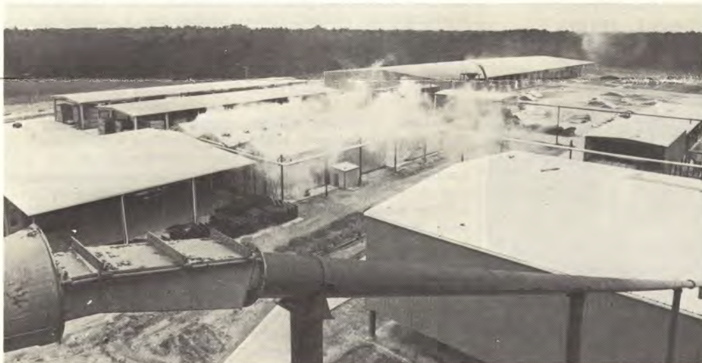
Leaf Riverin laajennus käsitti uuden sahaus- ja lajittelulinjan, jotka näkyvät alhaalla oikealla sekä kolmannen kuivaamon, joka höyryää kuvan keskellä. Lisäksi laajennettiin valmiin tavaran varastoa, joka näkyy kuvan yläreunassa oikealla. Sahan tuotanto myydään lähes kokonaisuudessaan Yhdysvaltojen etelävaltioihin ja itärannikon osavaltioihin.
