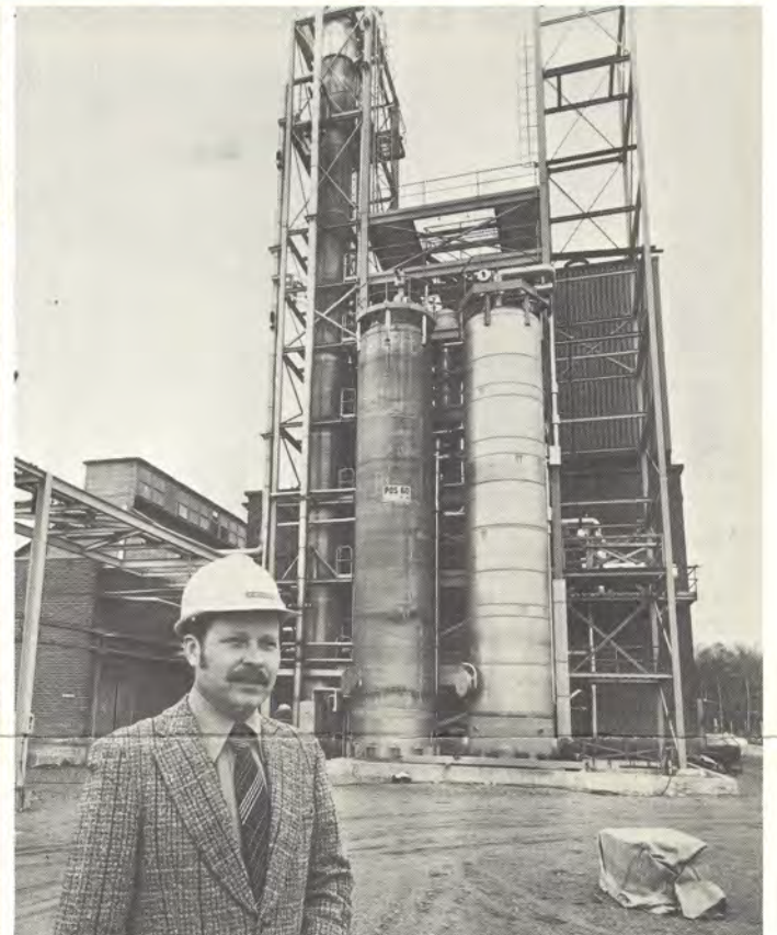
Oy Finnish Peroxides Ab:n tehtaan laajentaminen on käynnissä Voikkaalla. Käyttöinsinööri Seppo Meriluodon takana oikealla uutta laitteistoa vanhan vierellä.
