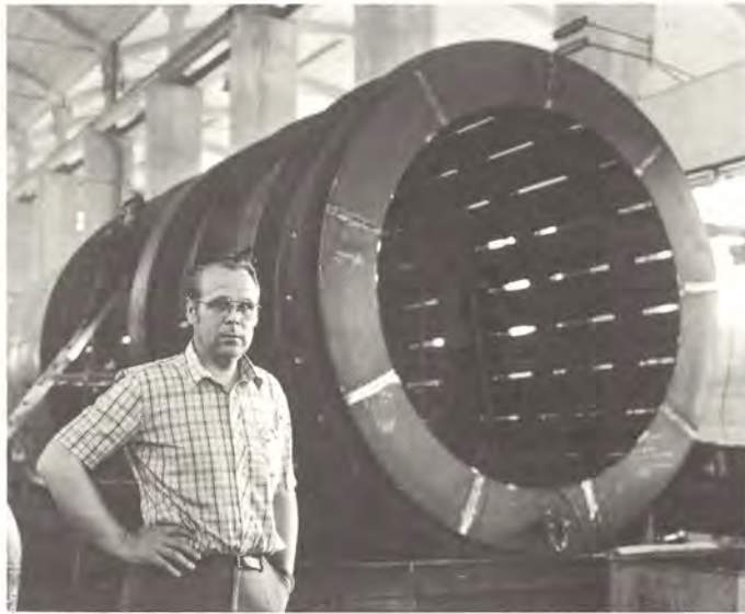
Voikkaan paperitehtaaseen tuleva uusi kuorimarumpu asennetaan paikoilleen heinäkuussa. Etualalla rumpun valmistaneen tuotelinja IV:n päällikkö, insinööri Juha Härmänsuo.
