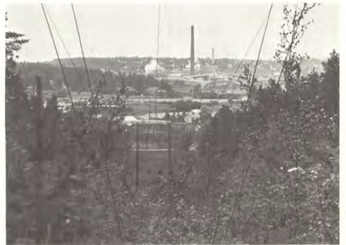
Korian ja Voikkaan välisen johdon puiset pylväätkä korvataan uusilla, niinkään puisilla pylväätkillä. Voikkaan päässä (kuva) merkittävin muutos on johdon siirtäminen sille asemakaavassa varattuun paikkaan Markantonttien alueella.
