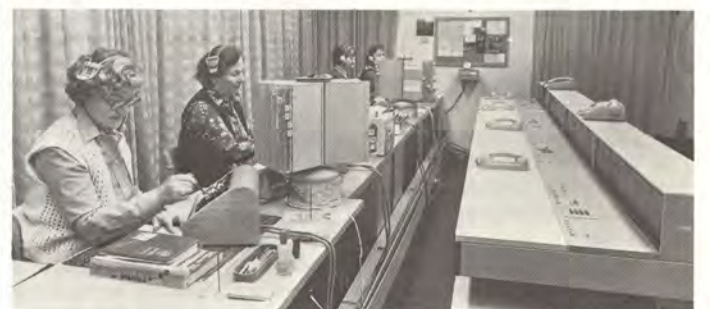
Siemensin toimittama virtaviivainen puhelinvaihdelaiteisto on odottamassa viikon päästä tapahtuvaa kytkentää pääkonttorin pohjakerroksen keskushuoneessa. Samalla vanhat 'sentraaliloorat' siirtyvät museoesineiden joukkoon.
