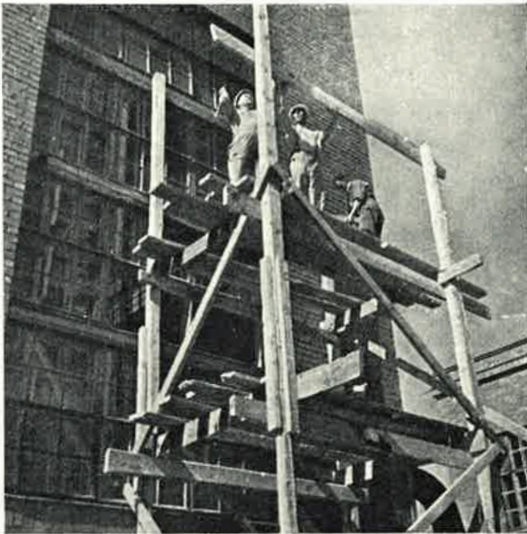
Ylhäällä: Kirvesmies Hugo Lahti apulaisineen rakentamassa vahvoja telineitä Kymen höyryjakokeskuksen seinustalla. Jokaisella puulla on tässä rakennelmassa oma tärkeä tehtävänsä.
