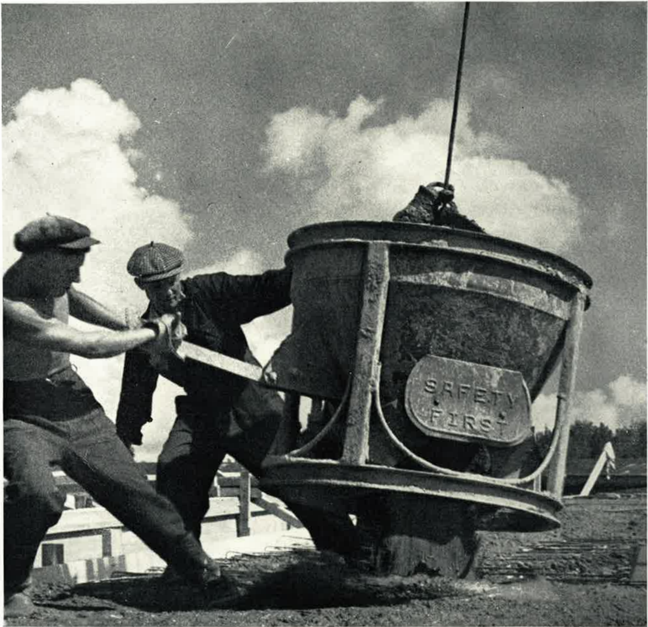
Miehistä kuntoa, tekniikkaa ja heinäkuista auringonpaistetta. Betoninvalu käynnissä Kymen uuden selluloosavaraston katolla.
