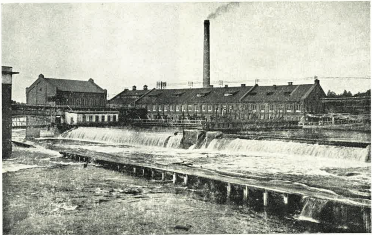
Kosken toisella sivustalla virtasi vesi aikanaan Kuusaan saaren ränniä myöten. Se lopetti toimintansa jo viime sotien aikana. Padon kivirakennelmat ovat vielä jäljellä. Keskellä koskea uittoruuhi, ns. Bonsdorffin ränni. — Alhaalla: Kymän rännin kouruosan räutakehikkoo asetetaan paikoilleen v. 1927.
