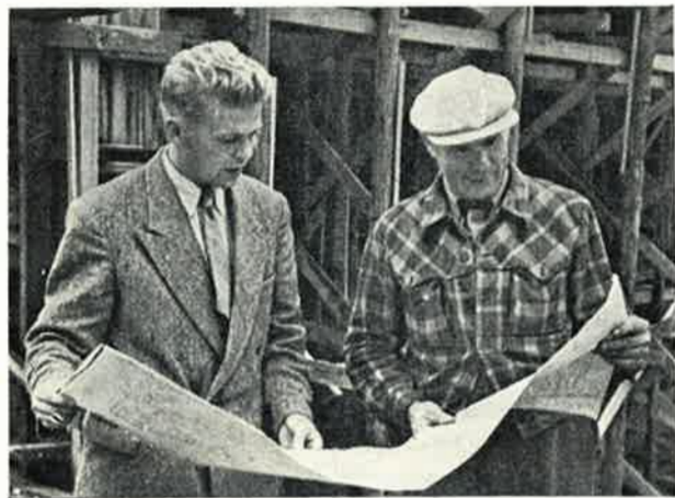
Dipl.ins. Uolevi Kuningas ja kirvesmies Kalle Rautjärvi tarkastelemassa piirustusta uuden selluloosavaraoston rakennustyömaalla.
